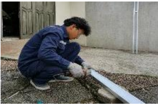
Gambar 4. Proses Pembuatan Tiang PJU Panel Surya
