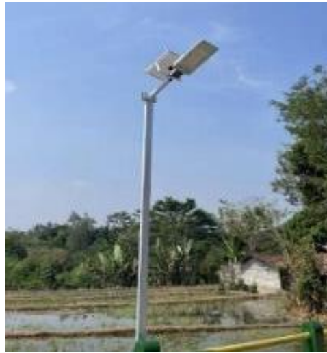
Gambar 5. Hasil Pemasangan PJU Panel Surya di Lokasi Mitra
