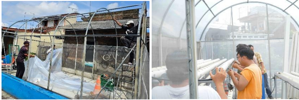
Gambar 2. Kegiatan Perbaikan Green House dan Pemasangan Instalasi Hidroponik NFT
