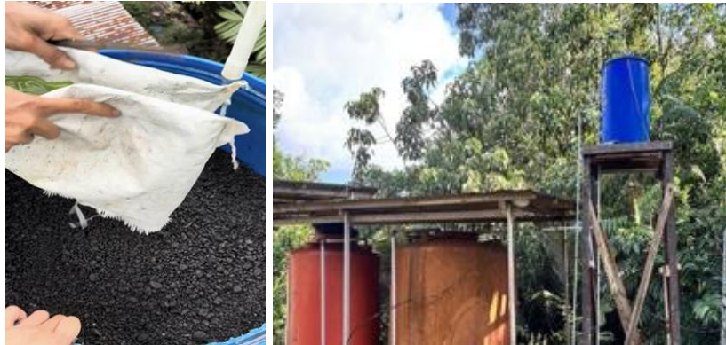
Gambar 2. Proses Pemasangan Media Filter di Lokasi Mitra
