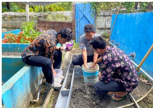
Gambar 4. Proses Penggunaan Media Filter Batu Kerikil, Pasir, Zeolit dan Busa
