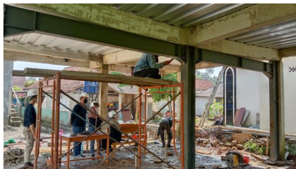
Gambar 4. Proses Pemasangan Baja Pada Bangunan Gedung Gagal Konstruksi
