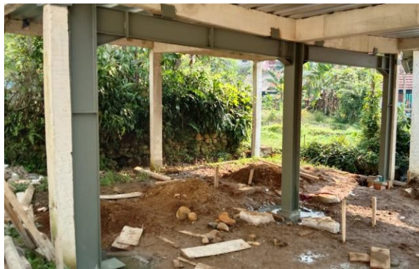
Gambar 5. Kondisi Bangunan Gedung Setelah Dilakukan Perbaikan
