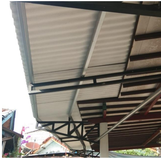
Gambar 4. Kondisi atap musholla Al-Amin setelah diperbaiki
