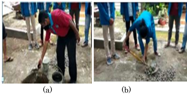
Gambar 5. Pelatihan pembuatan beton dan mortar: Pengukuran komposisi campuran beton (a), Pencampuran beton secara manual (b)
