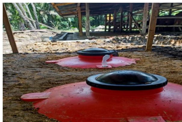
Gambar 8. Pemasangan Reaktor Biogas di sekitar Kandang Sapi
