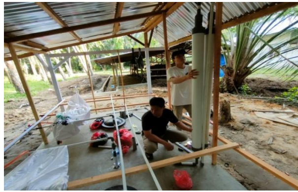
Gambar 9. Pemasangan Pemurnian Biogas pada Bangunan Atas Reaktor Biogas
