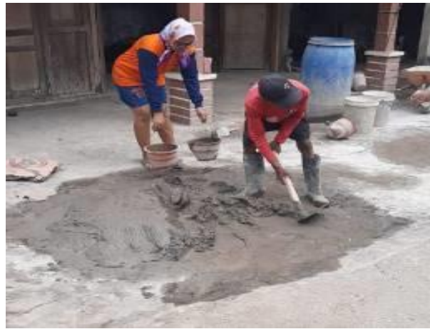
Gambar 2. Alat sederhana dalam pembangunan infrastruktur
