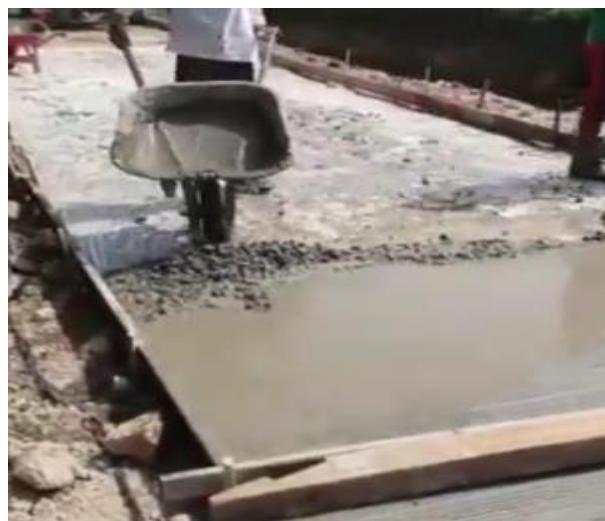
Gambar 8. Proses pengecoran jalan
