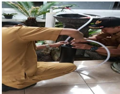
Gambar 5 Pemasangan Media Penyaring Air di Desa Sumberagung
