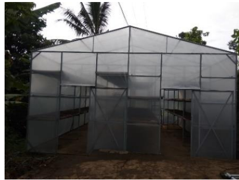
Gambar 3. Kondisi Dome Sesudah Perbaikan (Sumber : Dokumen Pribadi)
