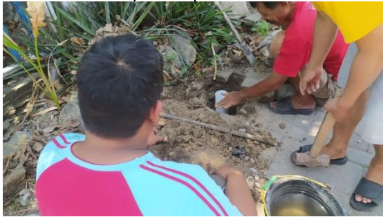
Gambar 5. Proses pemasangan resapan biopori
