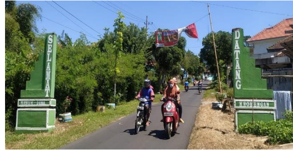
Gambar 2. Kondisi Eksisting Gapura Desa Kromengan, Kecamatan Kromengan, Kabupaten Malang Sumber: Dokumentasi Pribadi
