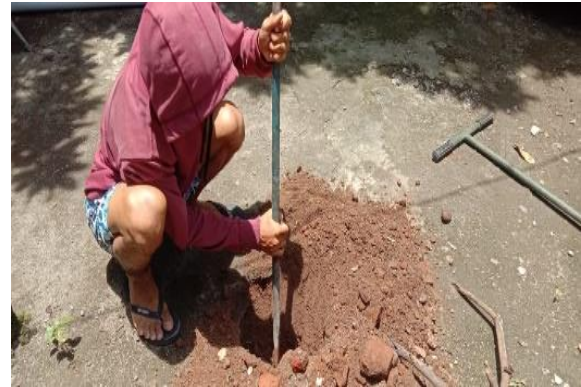
Gambar 2. Penggalian Lubang. (Sumber : koleksi pribadi)
