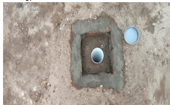
Gambar 5. Pengerasan Bibir Lubang Biopori (Sumber : koleksi pribadi)
