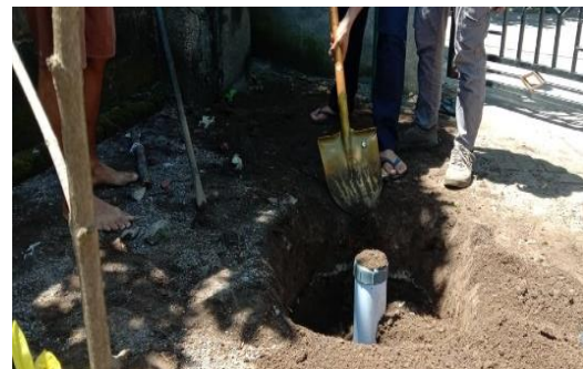
Gambar 3. Penimbunan pipa (Sumber : koleksi pribadi)
