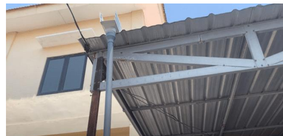
Gambar 10. Sambungan antara Talang air dengan Pipa Paralon
