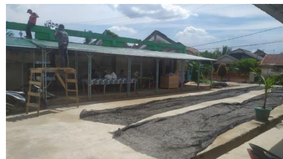
Gambar 3. Pembangunan Kios pasar Sekojo
