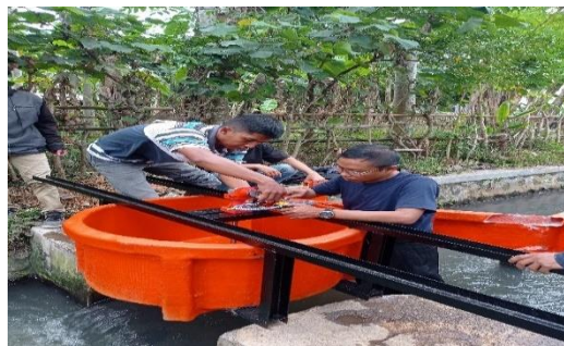
Gambar 9. Proses pemasangan alat
