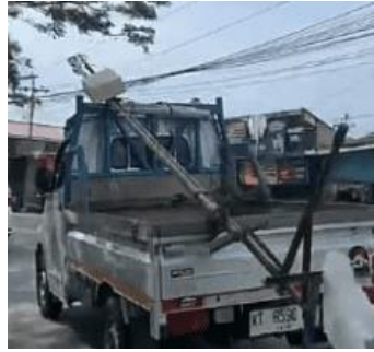
Gambar 4. Pengangkutan tiang listrik
