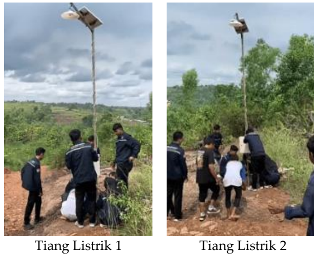
Gambar 6. Pengcoran 2 tiang listrik penerangan lampu jalan tenaga surya
