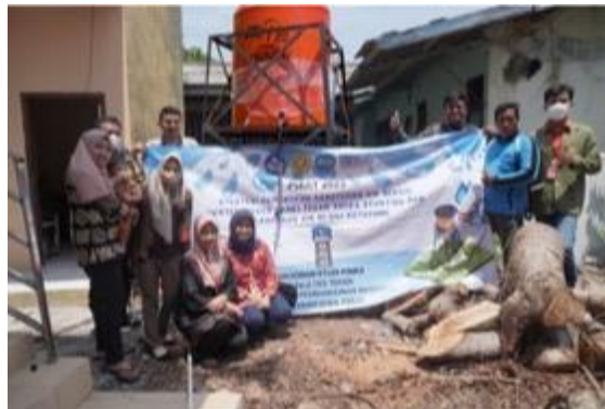
Gambar 6. Hasil Pembuatan Menara Tandon Air Bersama Warga Desa Gili Ketapang (Sumber: dokumentasi kegiatan, 2023)
