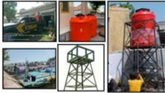
Gambar 5. Proses Pembuatan Menara Tandon Air Bersama Warga Desa Gili Ketapang (Sumber: dokumentasi kegiatan, 2023)
