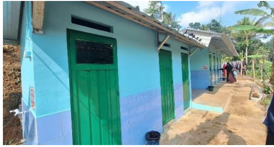
Gambar 5. Pembangunan Fasilitas yang Berada di Lokasi Aman Longsor
