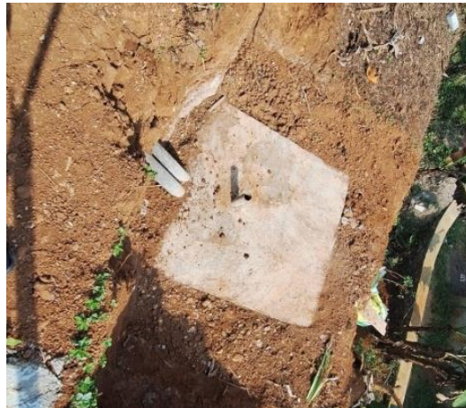
Gambar 6. Pembangunan Fasilitas WC yang dilengkapi oleh Septiktank
