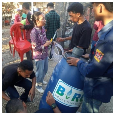
Gambar 3. Perakitan digester biogas
