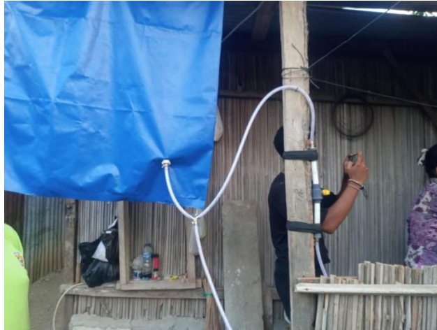
Gambar 4. Pemasangan selang dari digester ke kantong penyimpanan
