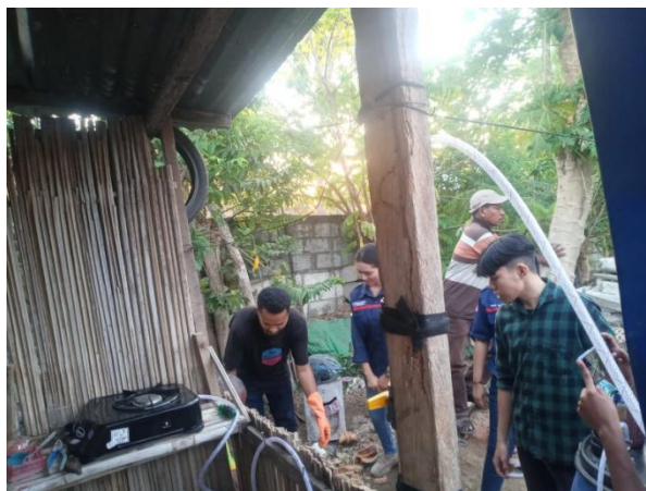
Gambar 5. Pemasangan selang ke kompor
