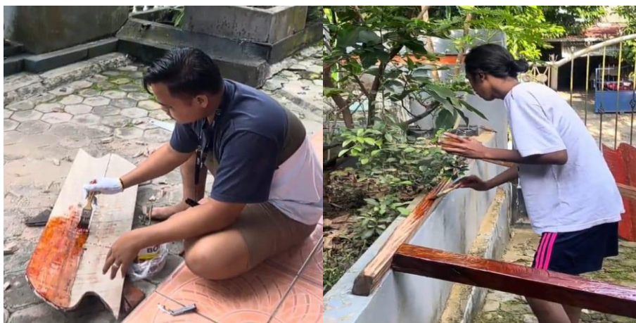
Gambar 6. Proses pembuatan gapura “Selamat Datang”
