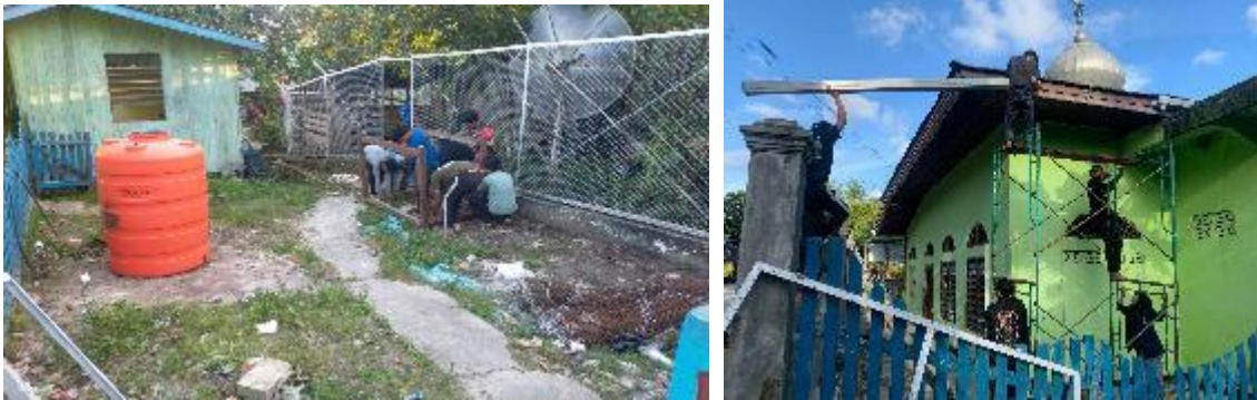
Gambar 8. Proses pemasangan RWHS pada atap masjid Baiturrahman bersama para warga.
