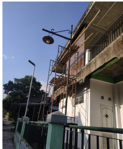
Gambar 2. Proses Pembangunan Lantai 2 Masjid Nurul Islam
