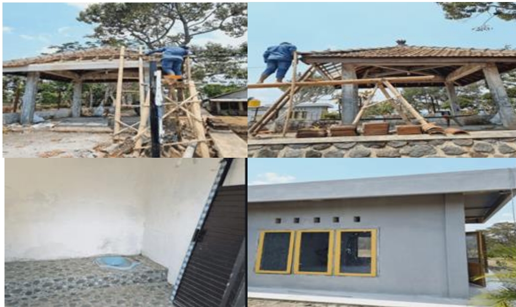
Gambar 7. Renovasi Toilet, Mushola, dan Gazebo
