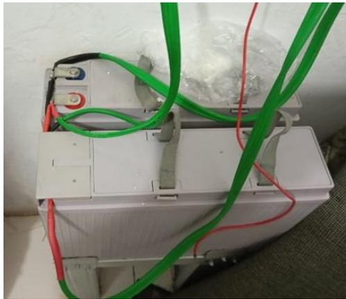
**Gambar 6.** Baterai VRLA 12V 100Ah Terpasang 2 (dua) Unit Terhubung Paralel
