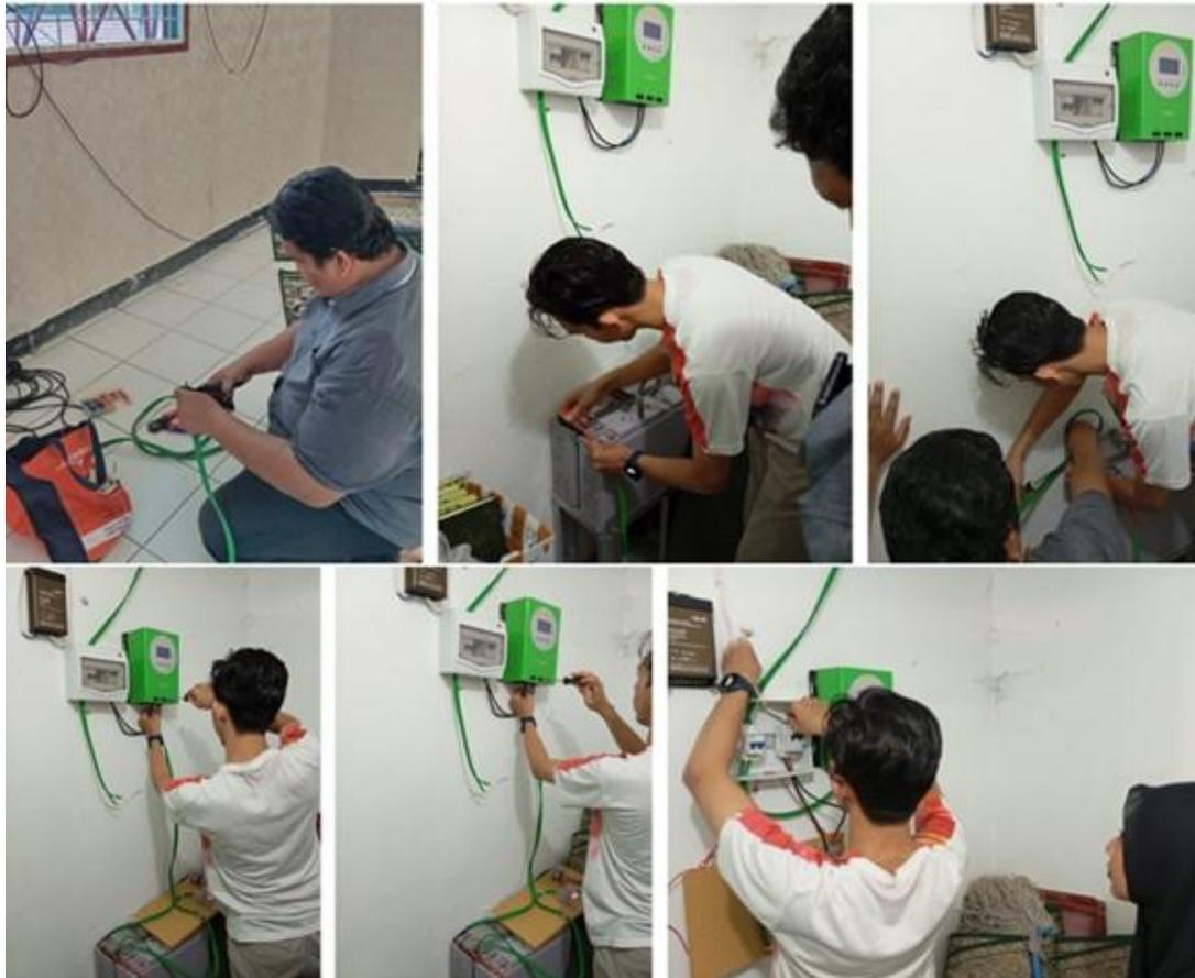
Gambar 10. Pemasangan Sistem *Hybrid* Sumber Energi Listrik Lampu Selasar PSTW
