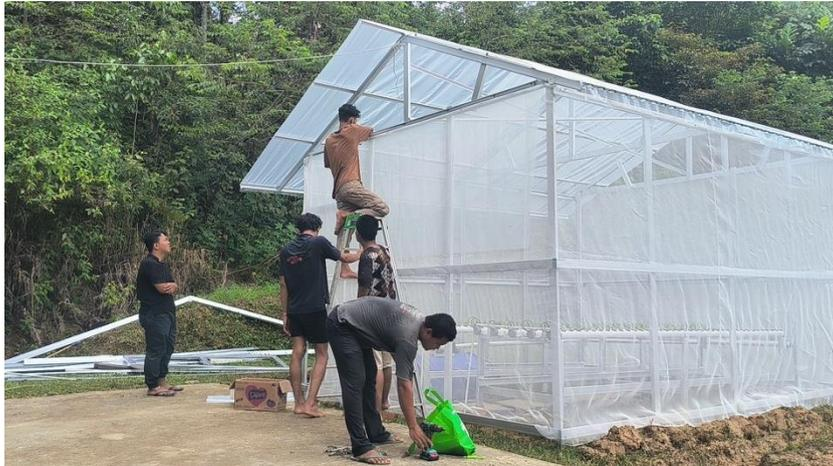
**Gambar 2.** Pemasangan atap plastik UV 200 mikron dan dinding *insectnet* 50 mesh pada *greenhouse*
