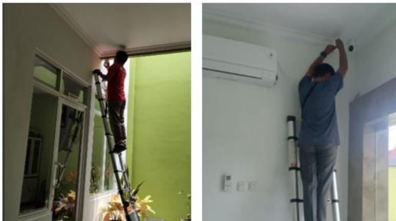
**Gambar 3.** Pemasangan Kamera CCTV
