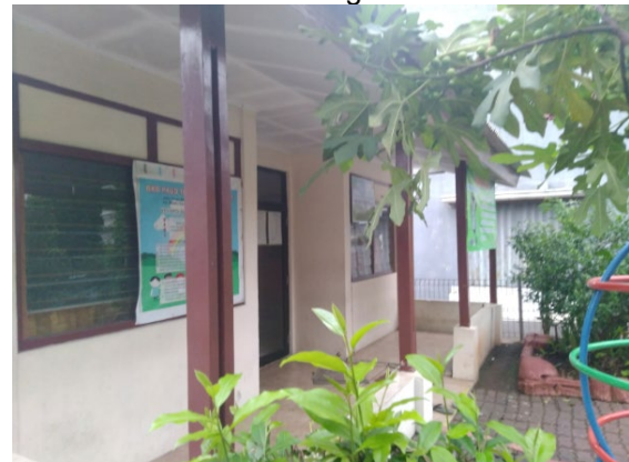
Gambar 1 : Kondisi Eksisting Depan Bangunan (Sumber : Survey, 2020)
