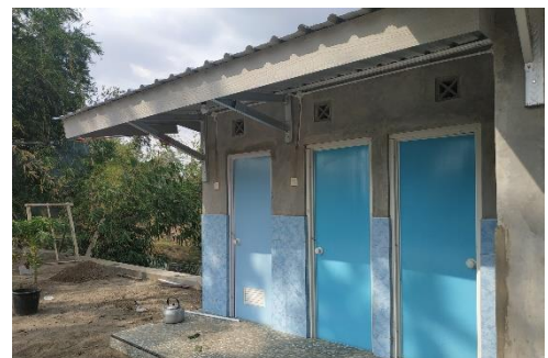
Gambar 5. Hasil Pembangunan toilet, sumur dan gudang
