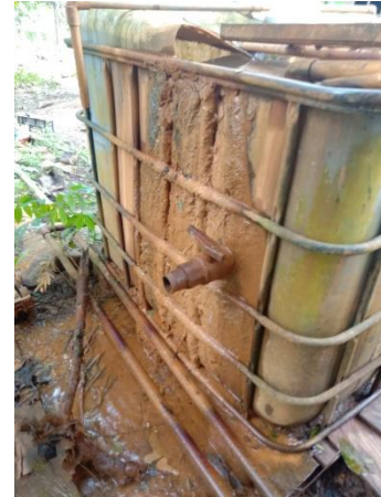
Gambar 1. Kondisi Eksisting Bak Filtrasi di Lokasi Mitra
