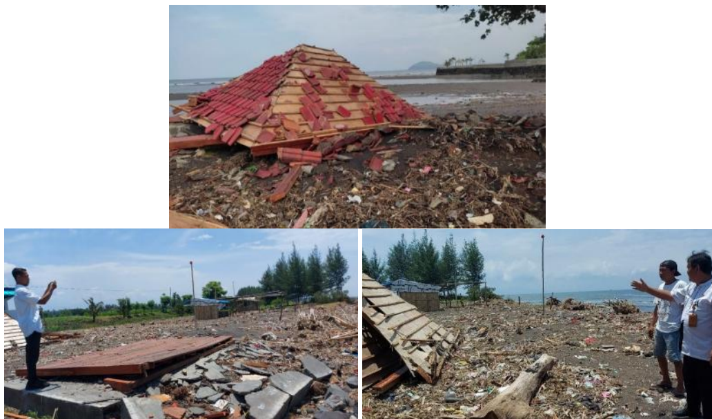
Gambar 1. Kondisi Segi Fasilitas Pantai Ria Bomo Setelah Terdampak Banjir Rob di Tahun 2024 (Editor actanews.id, 2024)
