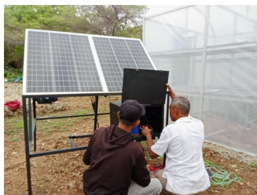
Gambar 4. Instalasi Solar Modul
