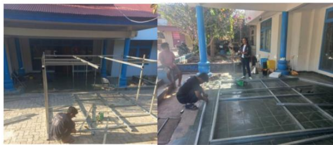
Gambar 2. Pembuatan Rangka Rumah Pengering
