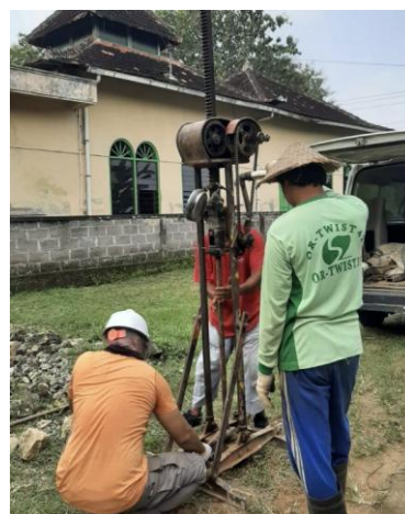
Gambar 4. Pengujian Sondir pada titik S2
