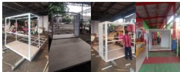
Gambar 9. Proses pembuatan cubicle portable
