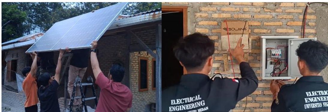
Gambar 4. Proses Pemasangan Panel Surya.
