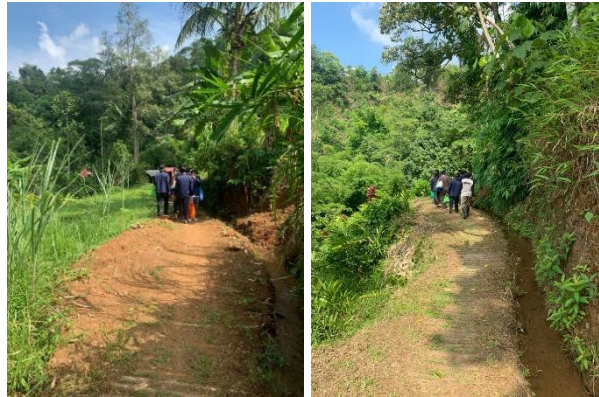
Gambar 4. (a) Jalan setapak berbatu, (b) Jalan setapak tanpa perkerasan.
