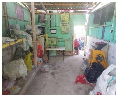
Gambar 5. Kerusakan Fasilitas di Bang Sampah Wonorejo 3
