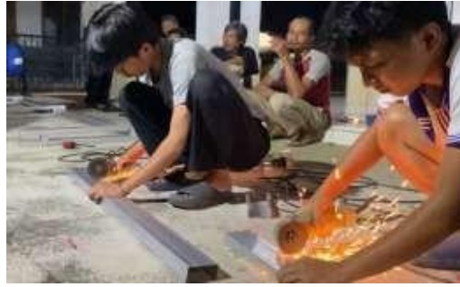
Gambar 3. Pemotongan baja untuk atap bak
