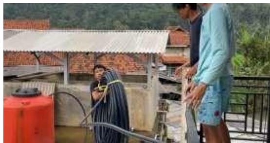
Gambar 4. Instalasi selang HDPE
