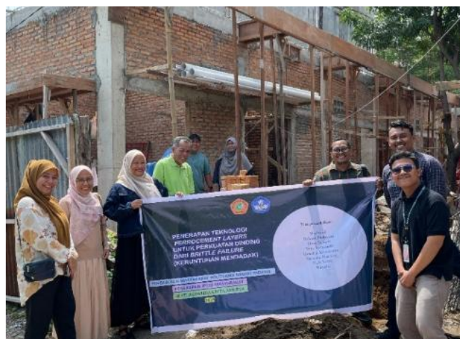
Gambar 4. Pelatihan teknis pada rumah yang sedang dibangun mitra.
