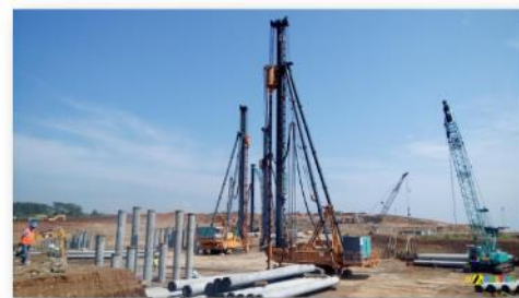
Gambar 3.5. Pondasi Tiang Pancang
