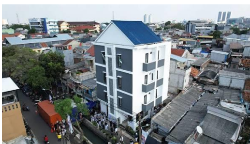
Gambar 5. Hasil Akhir Pembangunan Fisik Hunian KTV 4 Lantai di Kelurahan Tanah Tinggi (Sumber: Dokumentasi Kantah Jakarta Pusat / Dokumentasi Penelitian, 2026)
