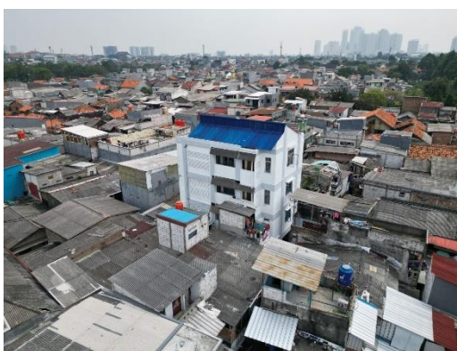
Gambar 3. Hasil Akhir Pembangunan Fisik Hunian KTV 4 Lantai di Kelurahan Palmerah (Sumber: Dokumentasi Kantah Jakarta Barat / Dokumentasi Penelitian, 2026)
