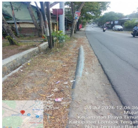
Gambar 3. Kondisi Pipa Jaringan
