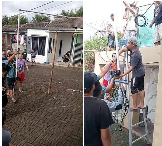
Gambar 2. Proses Pemasangan Pompa
